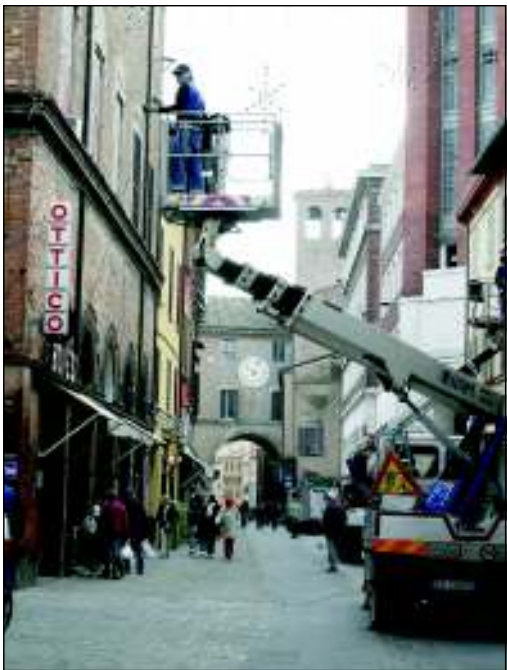
Il montaggio delle luminarie (Foto MMpress)
